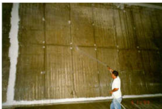
Zdjęcie 4. Spłukiwanie powierzchni przeznaczonej do pokrycia przeciwsiarczanową wersją MAXSEAL® lub MAXSEAL® SUPER , względnie MAXSEAL® FLEX . Proszę zwrócić uwagę na zabezpieczenie miejsc szczególnych: złączy „na zimno” i połączeń ścian z posadzką
