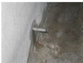
Zdjęcie 2. Zamontowanie rury w celu zmniejszenia wysokiego negatywnego ciśnienia hydrostatycznego
