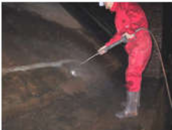
Zdjęcie 1. Przygotowanie podłoża poprzedzające aplikację powłoki hydroizolacyjnej opartej na cemencie
