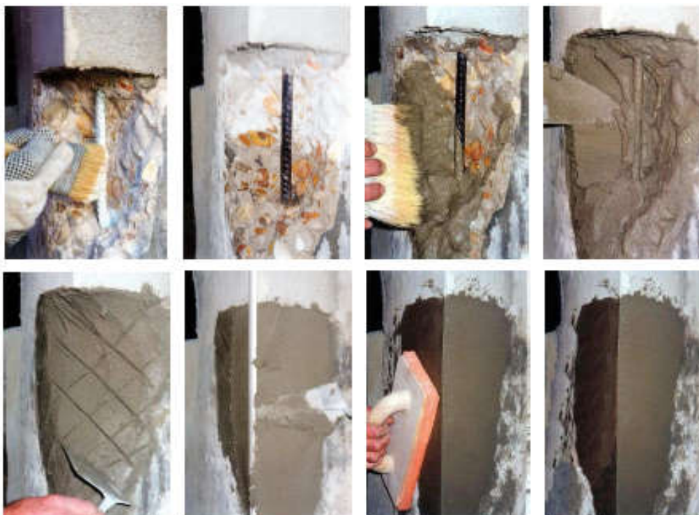
Zdjęcie 3 Poszczególne etapy aplikacji zaprawy DRIZORO ® do napraw strukturalnych
